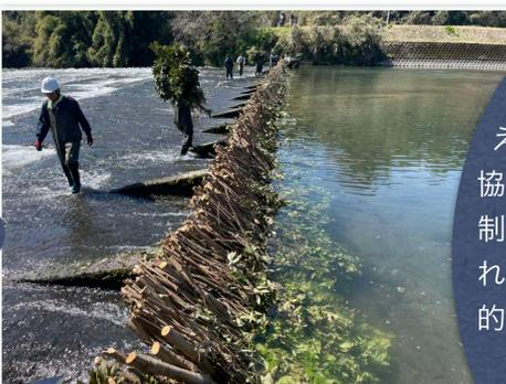
柴井堰 — 串良川に毎年3月頃に柴井堰が設置されると、下流側の農業用水路に水が送られる。近隣の山で伐採したマテバシイを用いて土地改良区事務所と地域住民の手作業で作られる。
